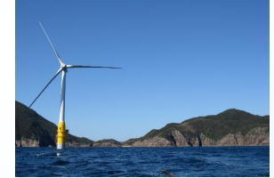
長崎県五島市杵島沖 浮体式洋上風力実証
